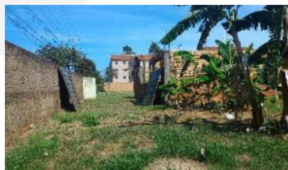
Obra inacabada no segmento ocupado
